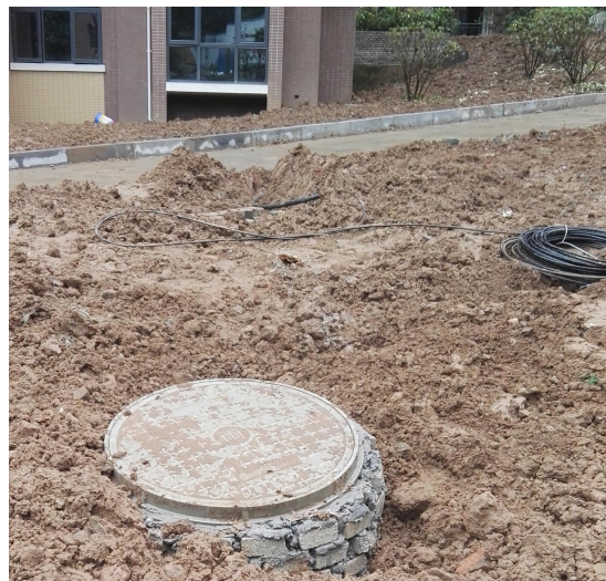
小区雨水排放口
