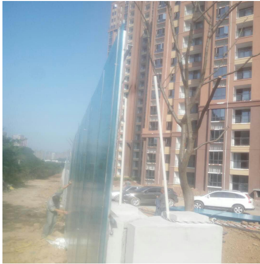
铁路沿线隔声屏障 1
