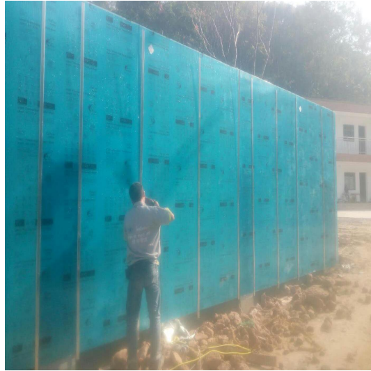
铁路沿线隔声屏障 2
