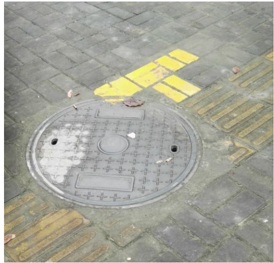
小区雨水排放口
