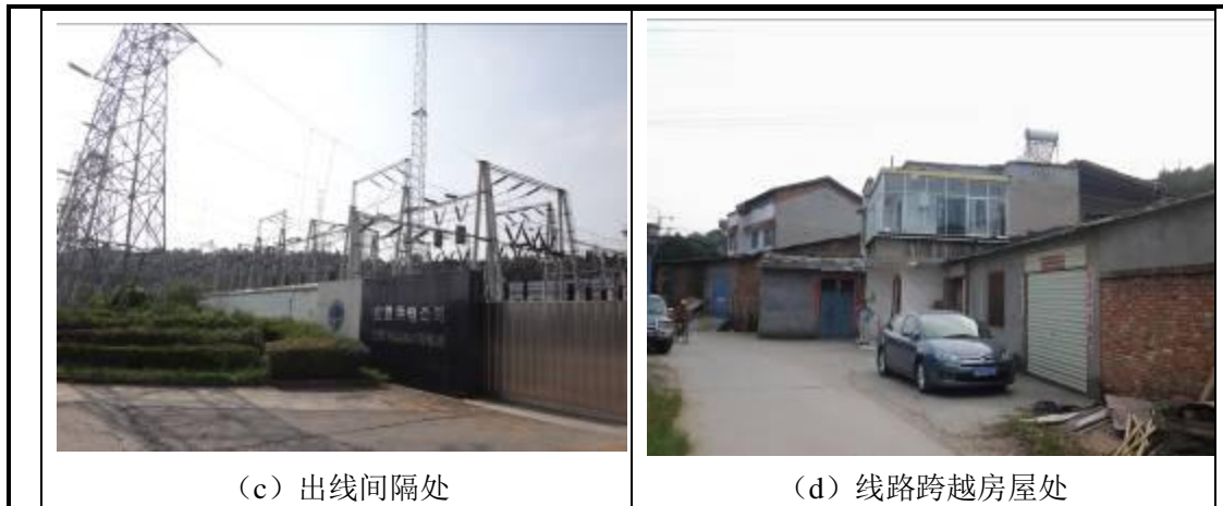
图3 本工程沿线周边环境
