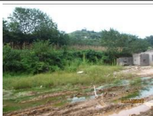
(a) 新建 110kV 合益变电站站址
