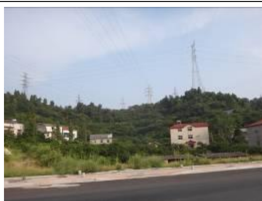
(d) 新建 110kV 线路跨越道路
