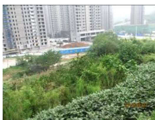
(b) 新建 110kV 合益变电站站址
