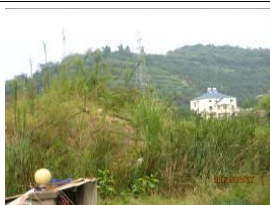
(c) 新建 110kV 线路沿山坡走线
