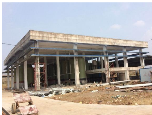
已建成的罐区
