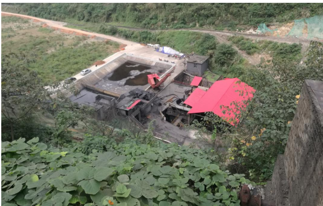
图 2.4-2 尾矿输送泵站现状（1#渣场边）
