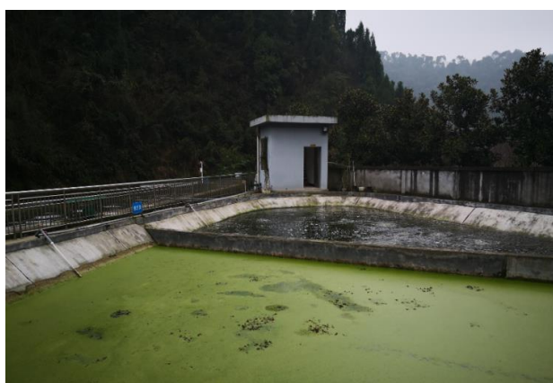
渗滤液处理站氧化塘
