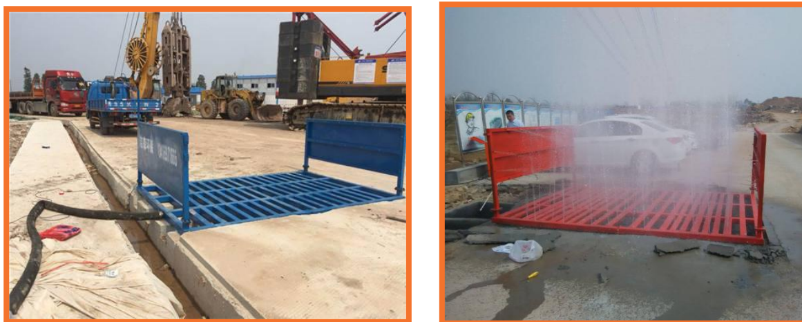
图8.7-2 洗车平台示意图
