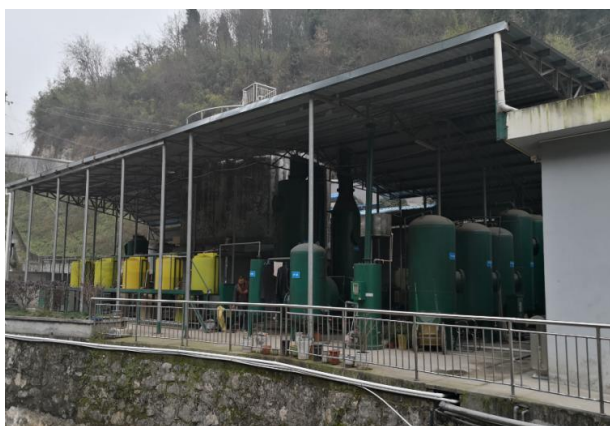
渗滤液处理站
