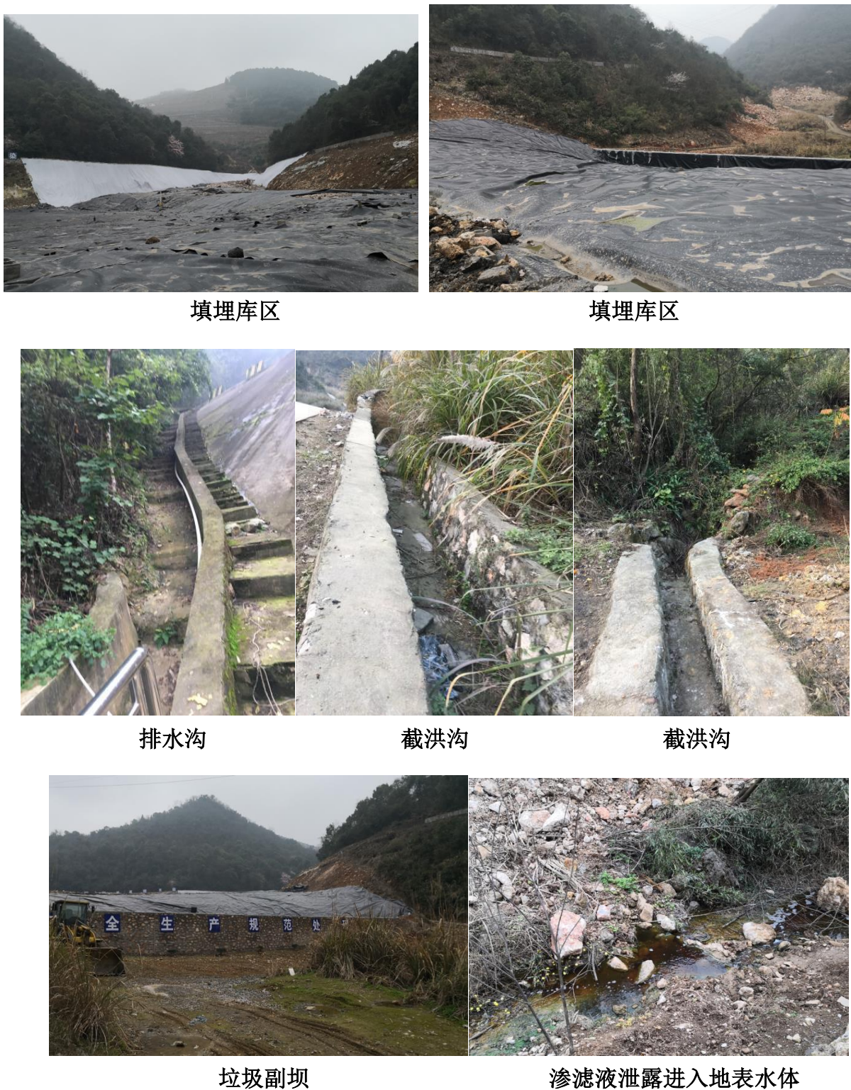
图 3.2-3 垃圾填埋场现状照片
