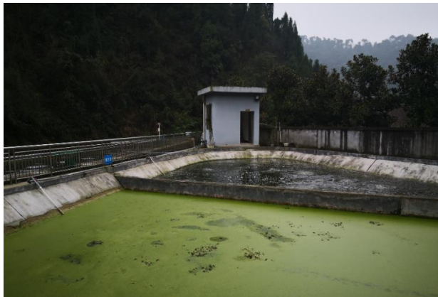
渗滤液处理站氧化塘
