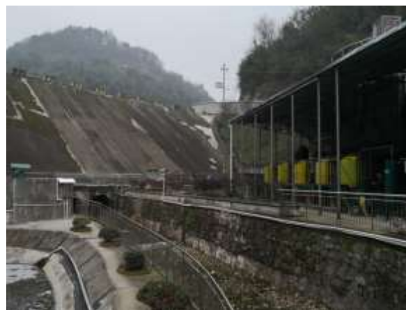
渗滤液处理站氧化塘
