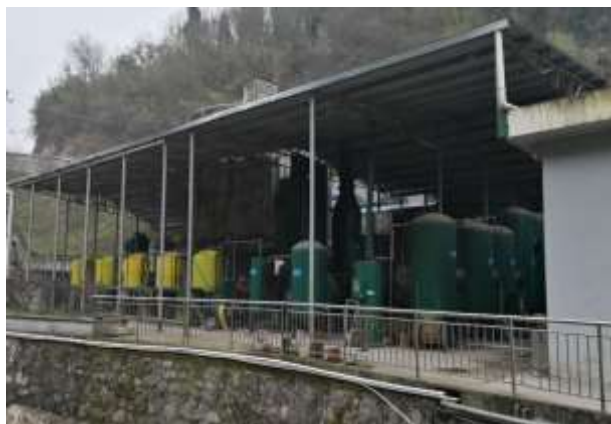
渗滤液处理站
