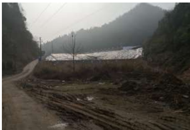
地下水监测井
