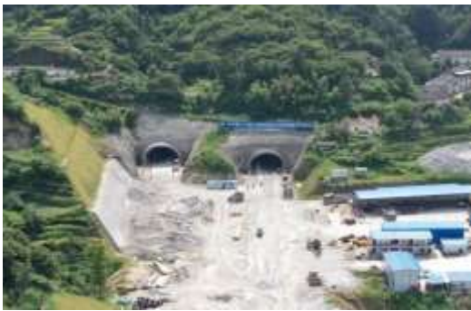
寨子包隧道出口现状（K3+965）
