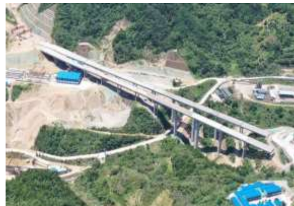
灯盏窝大桥已建成（K11+235）
