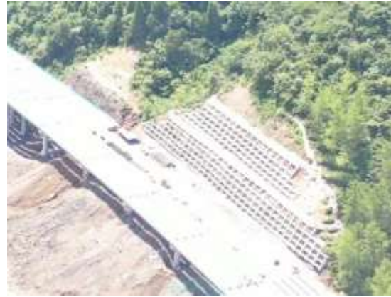
三维土工网植草防护（K23+500段）
