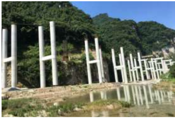
滴水岩大桥桩基工程（K29+815）
