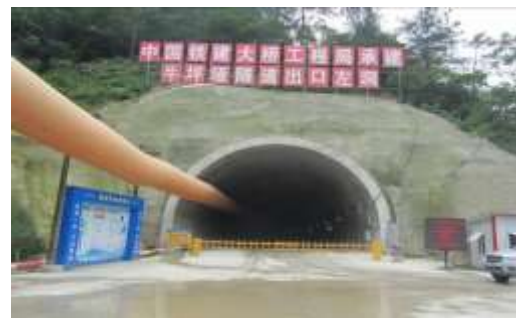
牛坪垭隧道出口现状（K25+990）
