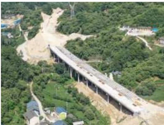
路西大桥已建成（K4+810）
