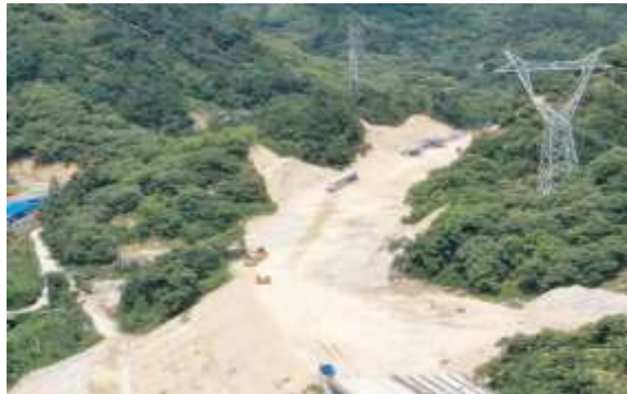
K5+500 路基现状
