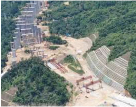
多级边坡防护（K9+500段）
