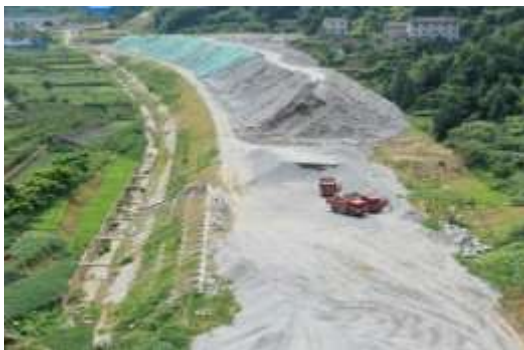
K1+300 路基现状
