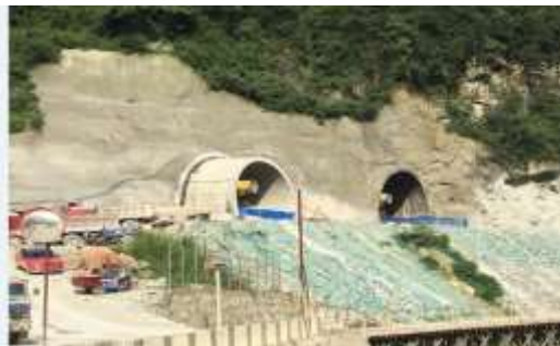
牛坪垭隧道入口现状（K21+911）
