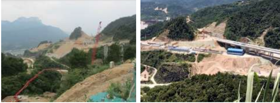
图 2.1-24 乐天溪互通工程施工现状
