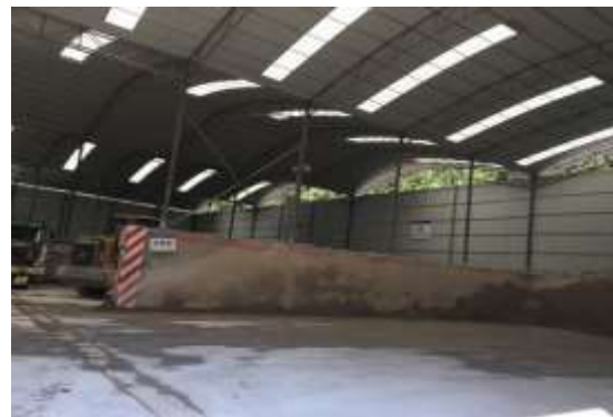
采取遮盖及围挡措施
