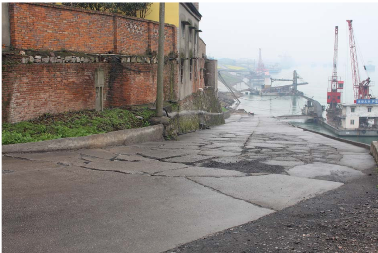
图 7.3-1 码头滑坡道现状
