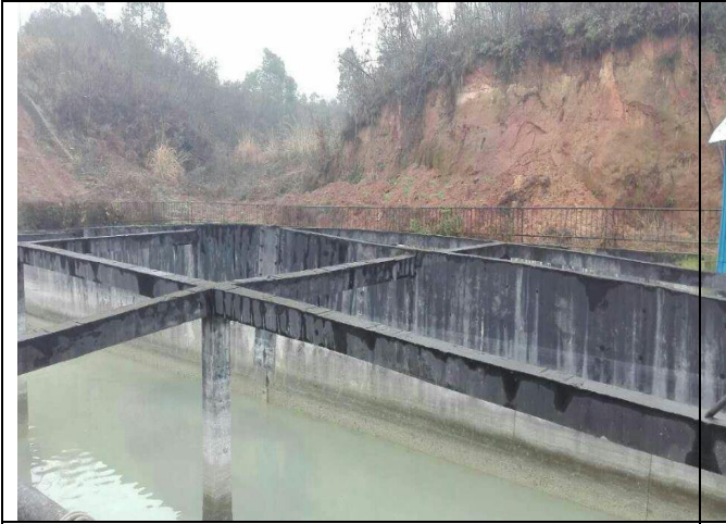
调节池现状照片
