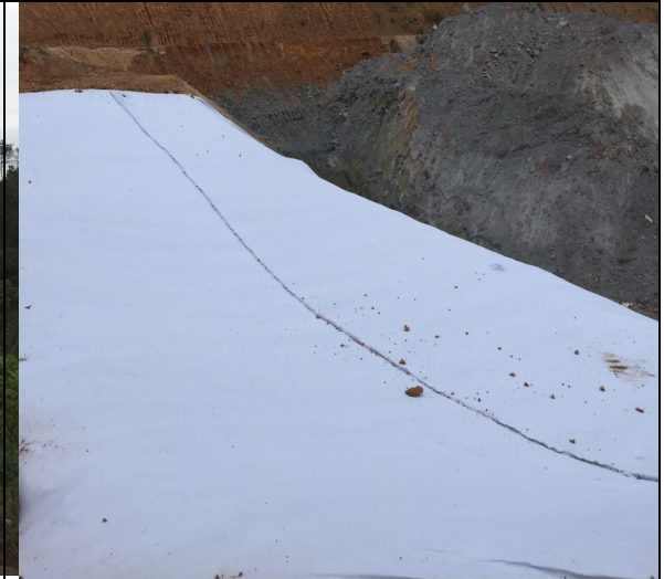
二期防渗措施施工
