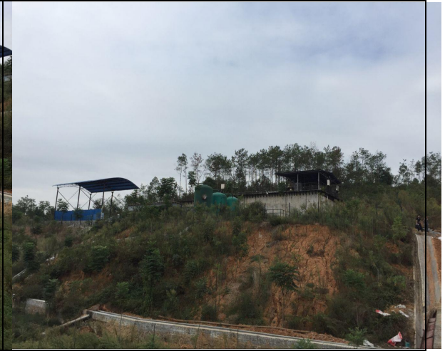
二期污水处理站
