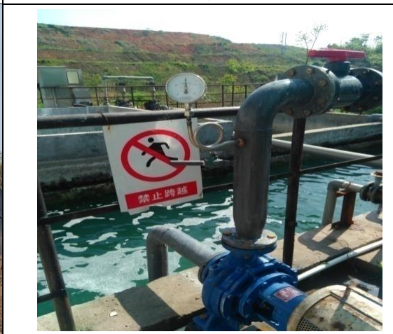
二期高位水池
