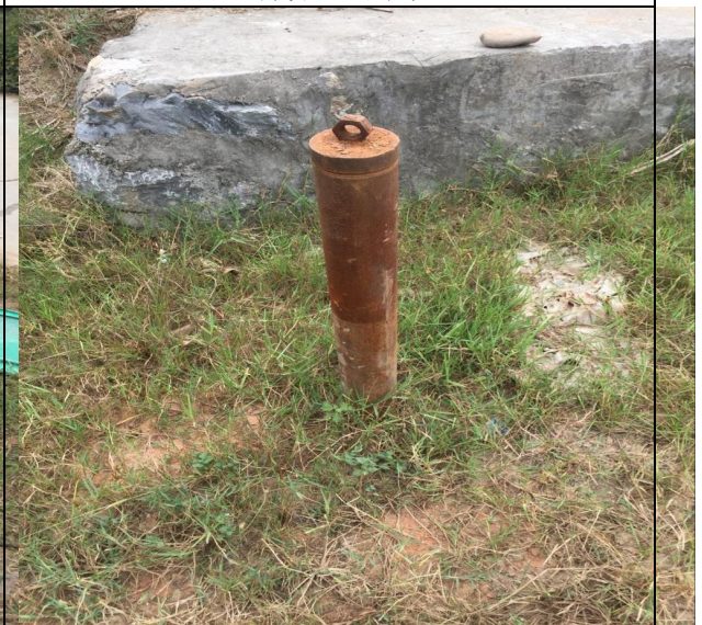
3#地下水监测井
