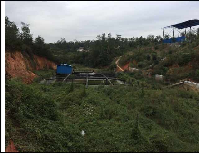
二期调节池现状
