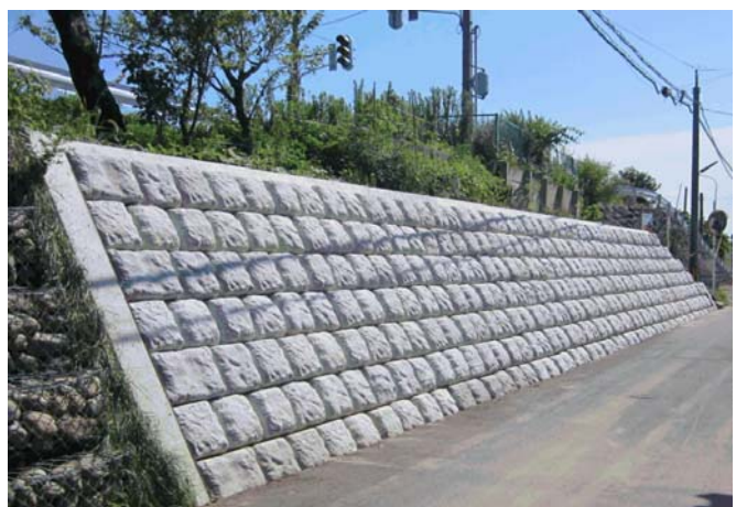
生态石挡土墙护坡
