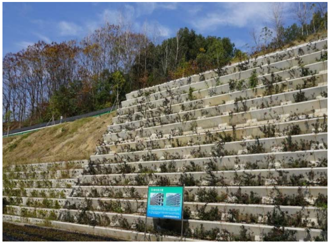
格构式挡土墙护坡
