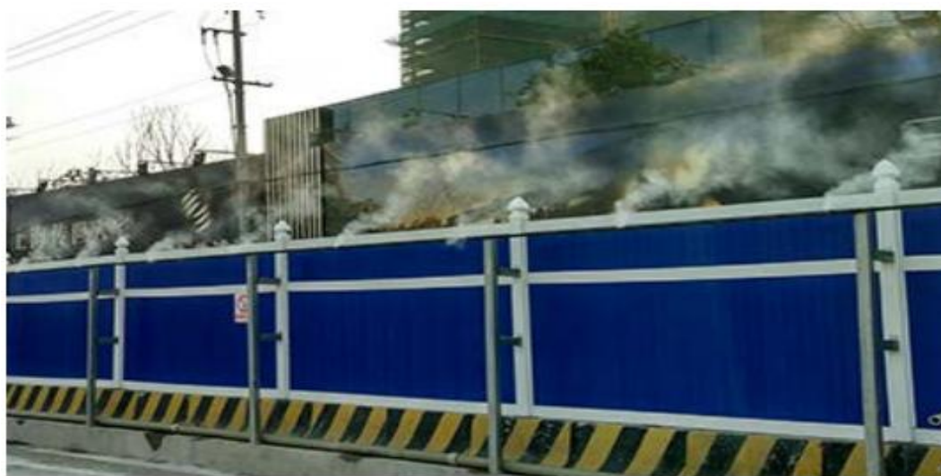
图 6.1-1 施工场地高压喷雾除尘示意图
