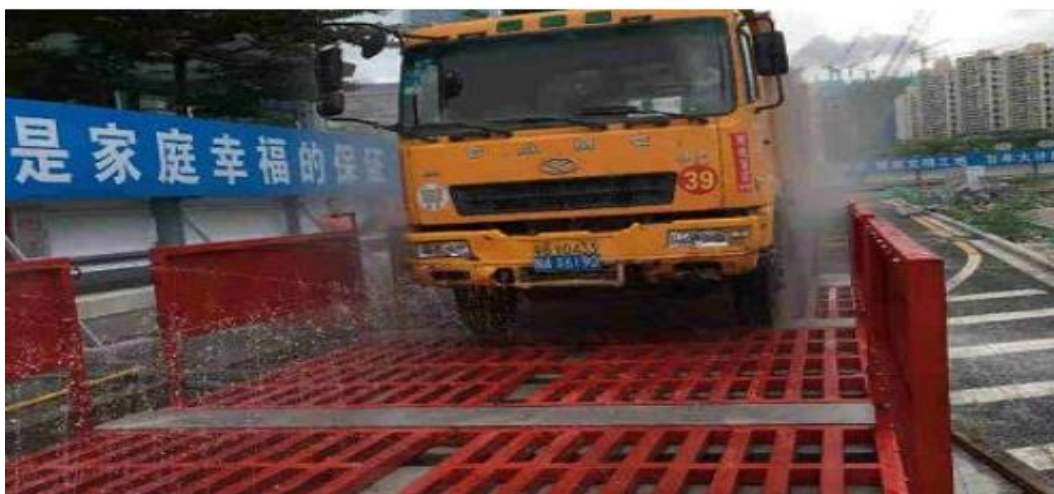
图 6.1-3 施工场地洗车平台示意图
