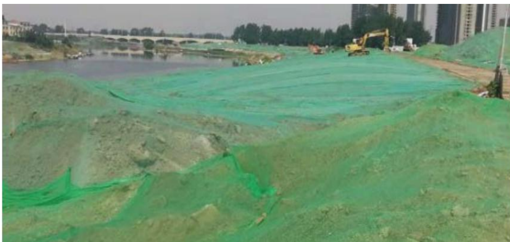
图 6.1-2 施工场地防尘网覆盖示意图
