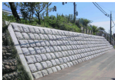
生态石挡土墙护坡
