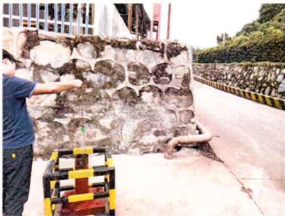
2#地下水监测井（☆2）
