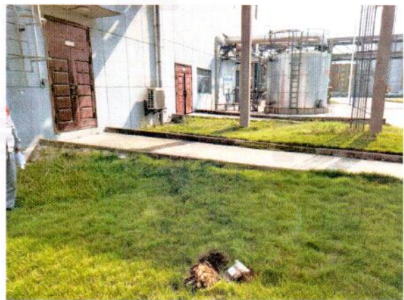
氯碱分厂二车间电解整流控制室门口 (□6)
