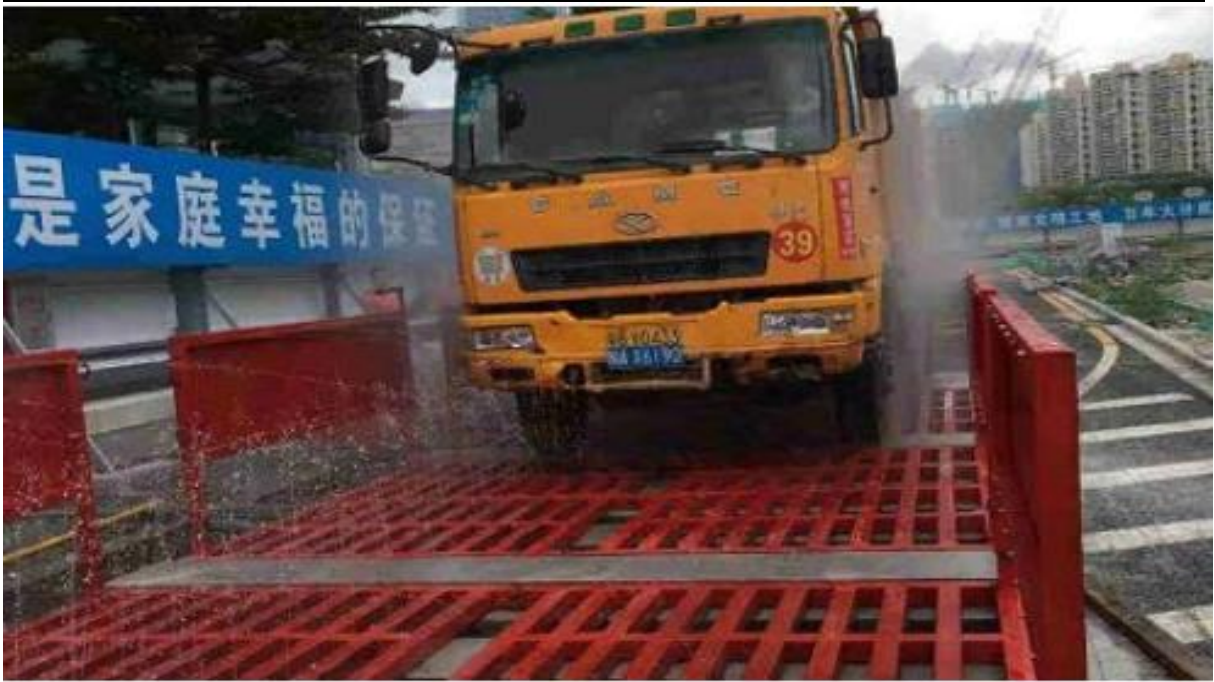
图 6.1-3 施工场地洗车平台示意图
