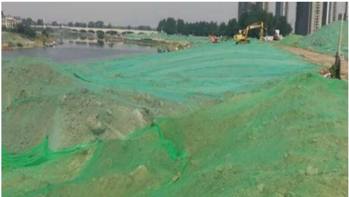
图 6.1-2 施工场地防尘网覆盖示意图
