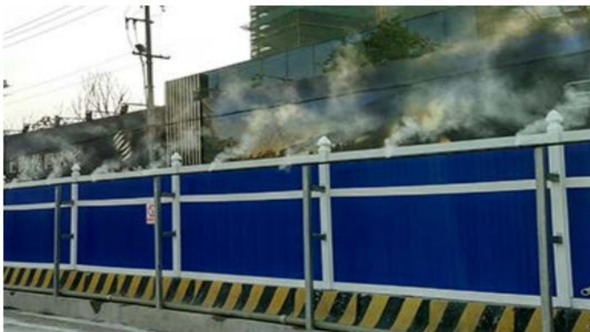
图 6.1-1 施工场地高压喷雾除尘示意图
