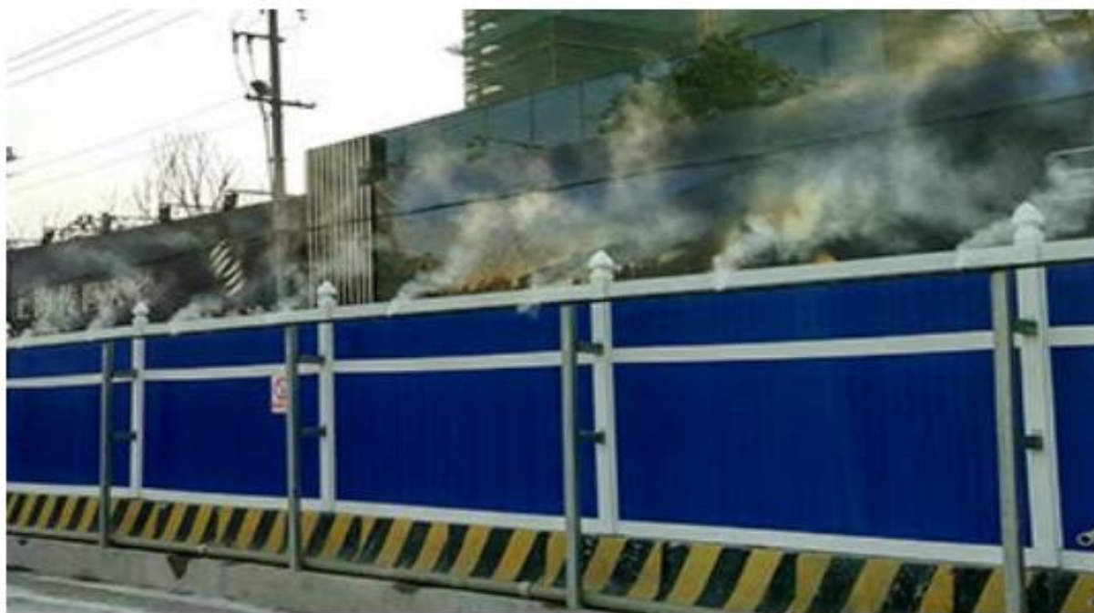
图 8.1-1 施工场地高压喷雾除尘示意图
