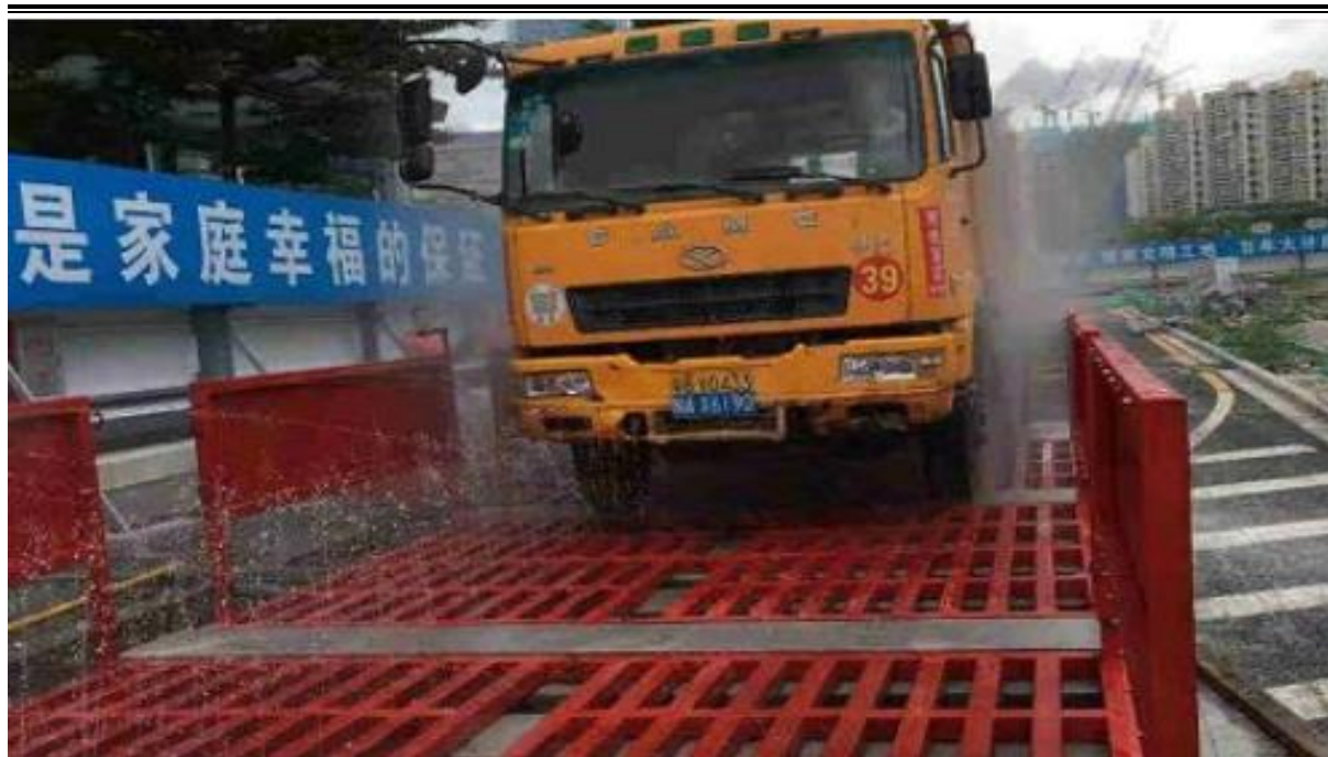
图 8.1-3 施工场地洗车平台示意图
