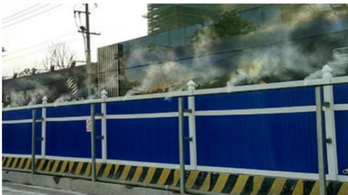
图 8.1-1 施工场地高压喷雾除尘示意图
