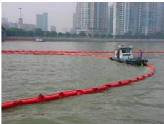
图 8.4-2 围油栏和吸油毡示意图
