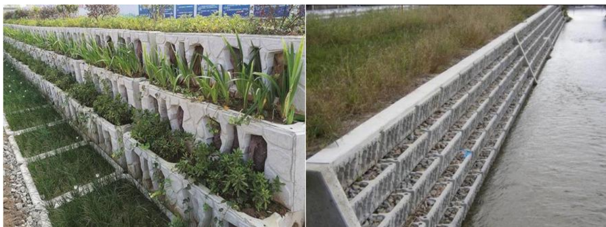
图 4.1-6 磷石膏生态护坡
