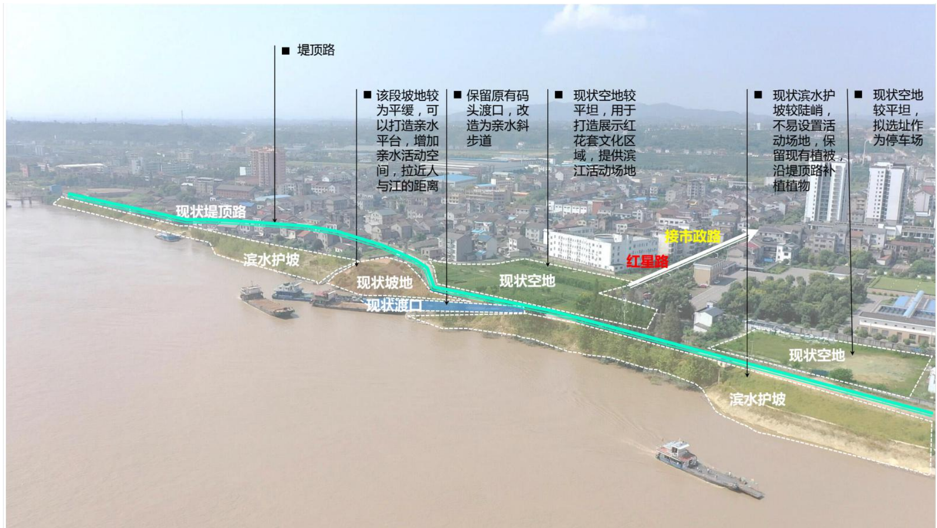
图 3.2-2 红花套片区项目工程选址现状图（南侧区域）
