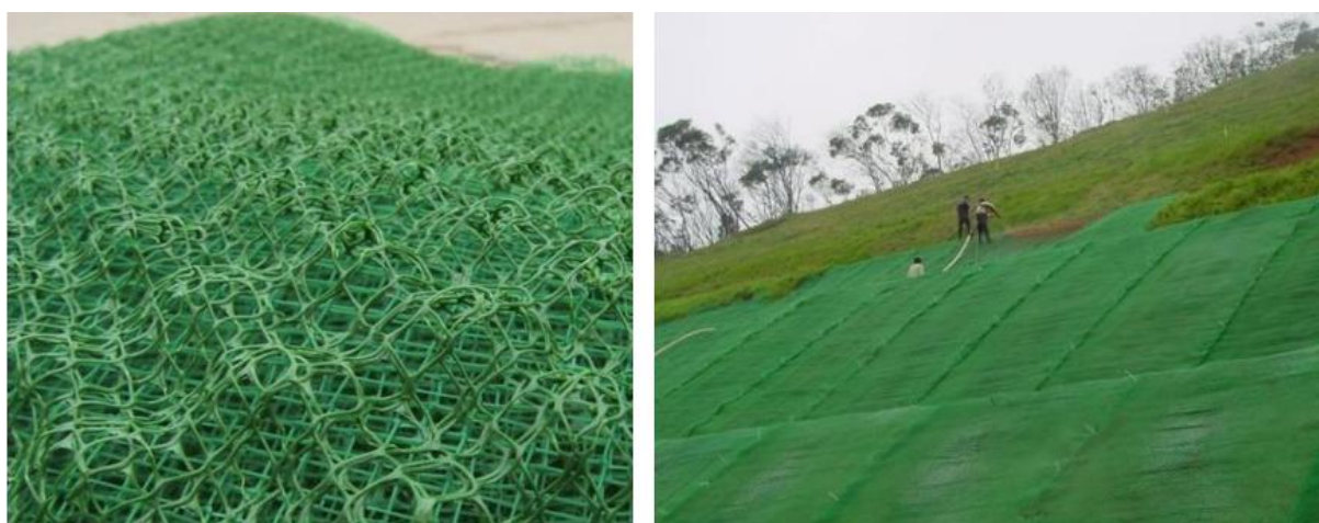
图 4.1-3 三维土工网垫护坡护坡
