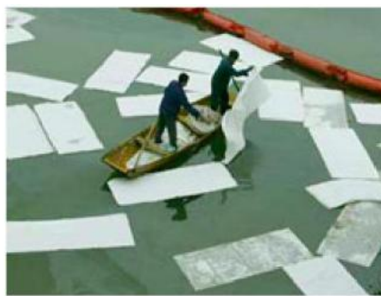
图 8.4-2 围油栏和吸油毡示意图
