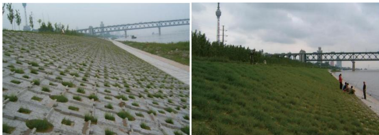
图 4.1-1 连锁式植生块护坡
