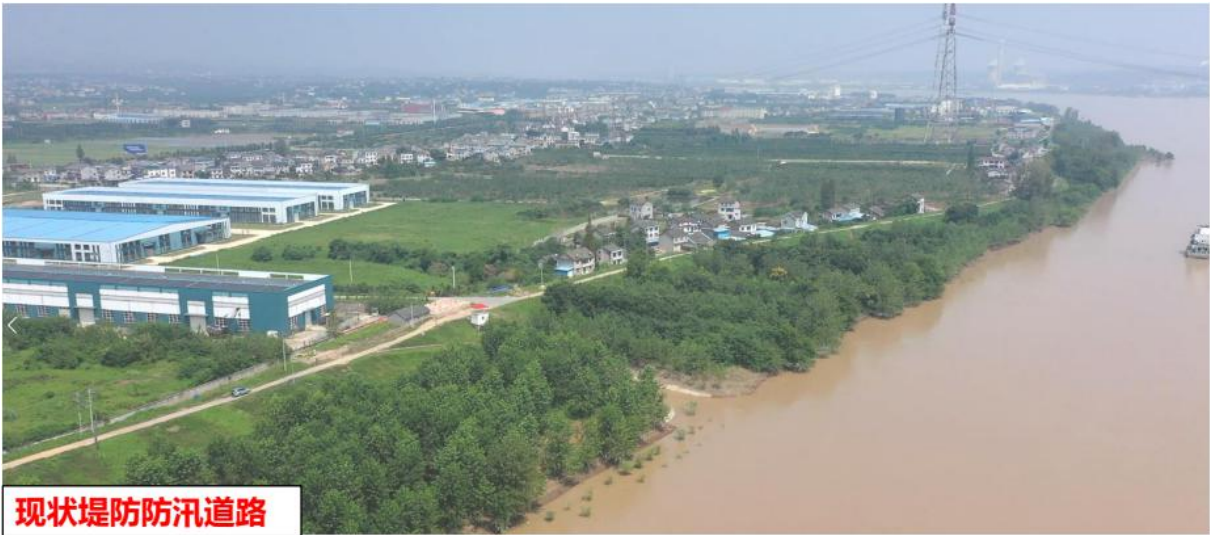
图 3.5-5 第Ⅱ段岸线现状图
