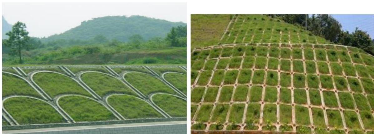
图 4.1-4 混凝土框格绿化护坡
