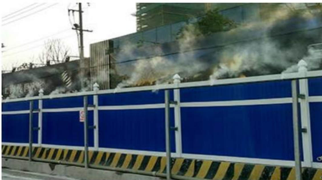
图 8.1-1 施工场地高压喷雾除尘示意图
