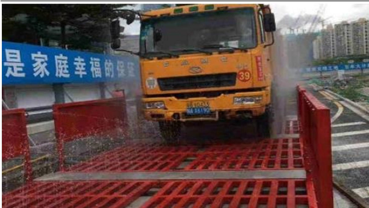
图 8.1-3 施工场地洗车平台示意图
