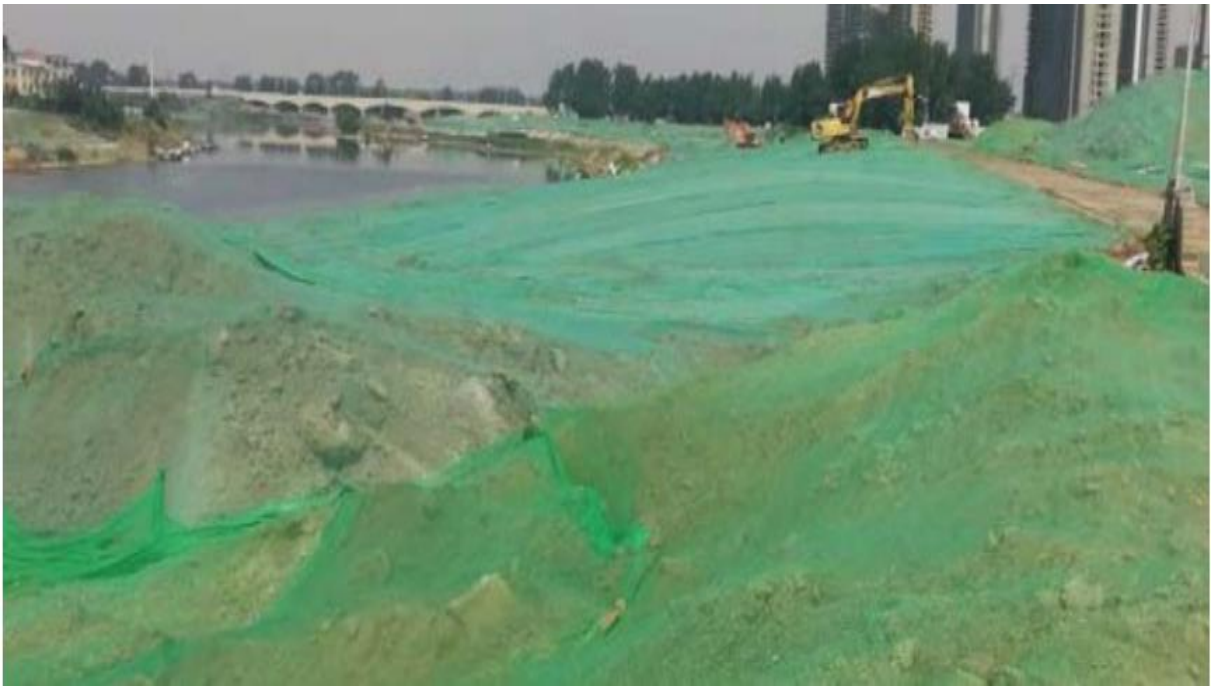
图 8.1-2 施工场地防尘网覆盖示意图
