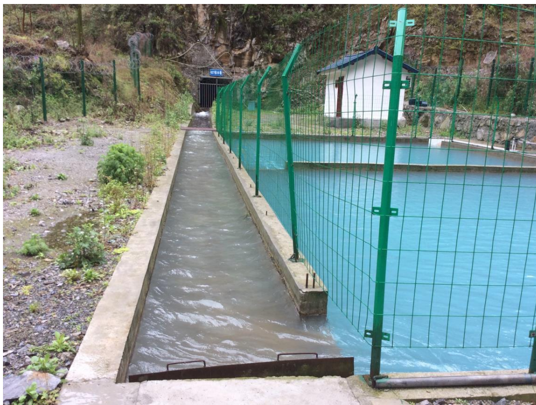
图 2.2-1 矿井水二级沉淀池
