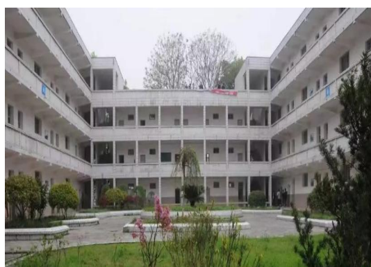
教学楼改造前
