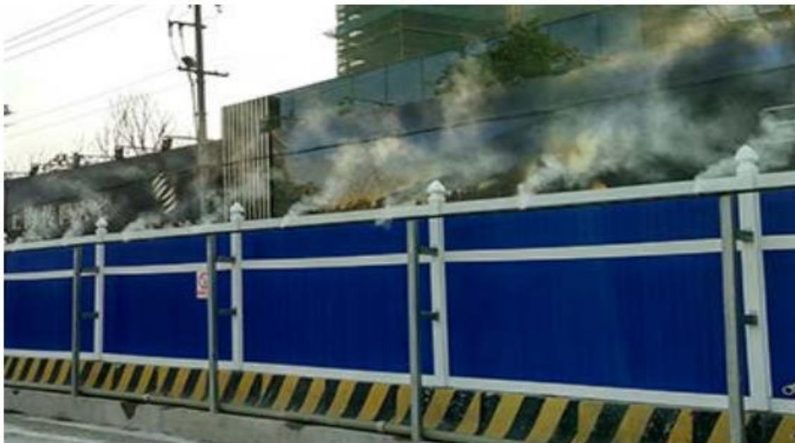
图 9.1-1 施工场地高压喷雾除尘示意图
