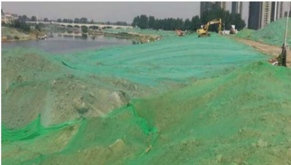
图 9.1-2 施工场地防尘网覆盖示意图
