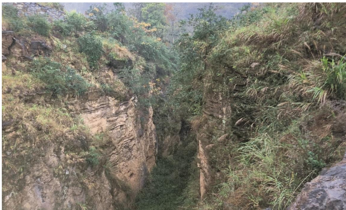
图 2.1-1 1#露天采坑现状
