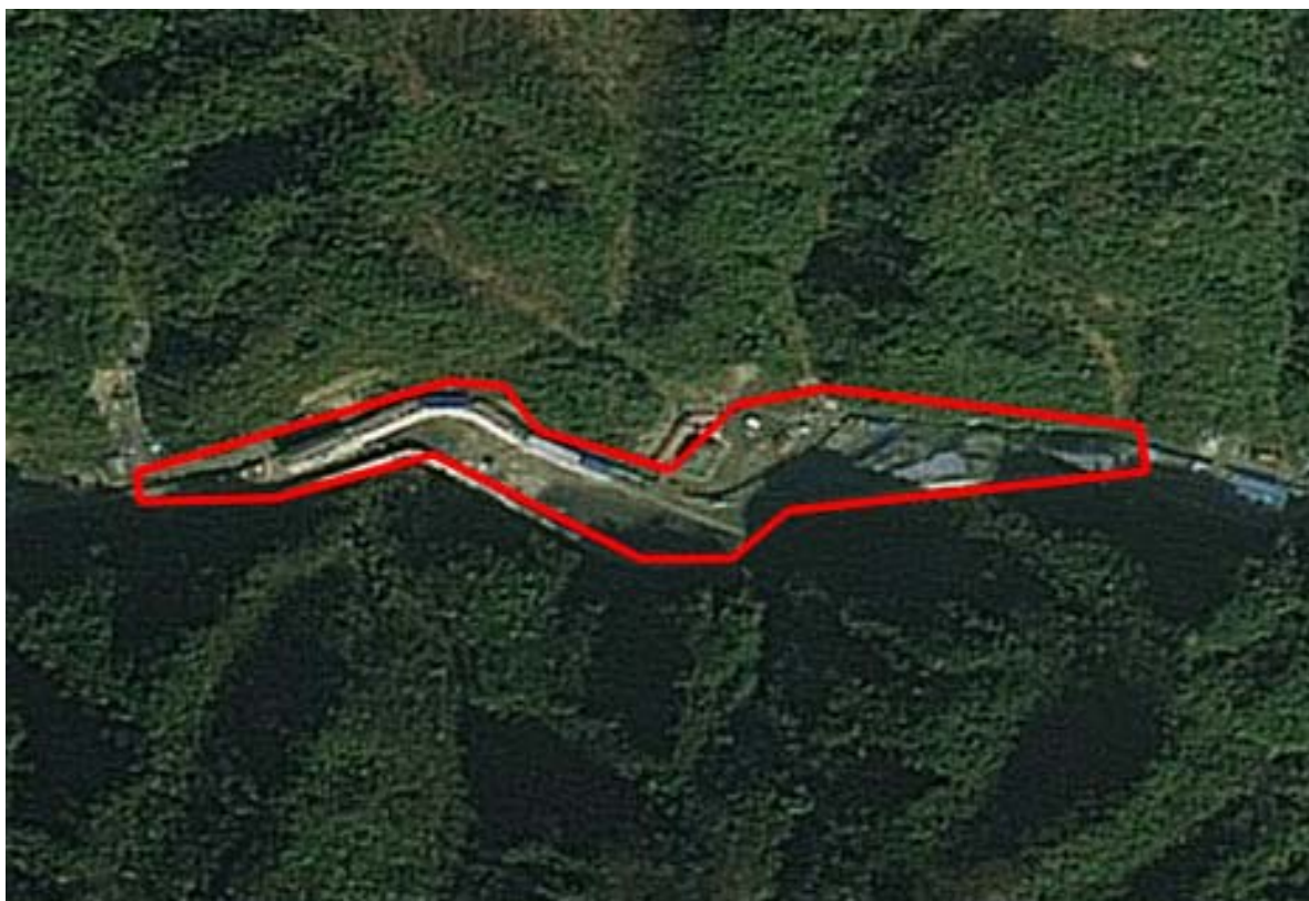
图 2.3-1 主胶带斜井和辅助斜坡道工业场地
