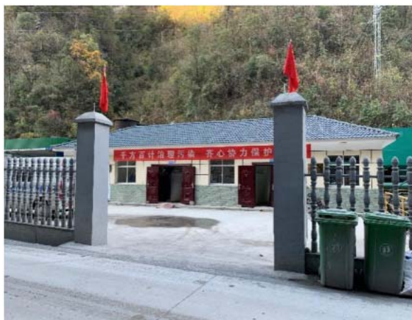
生产废水处理站
