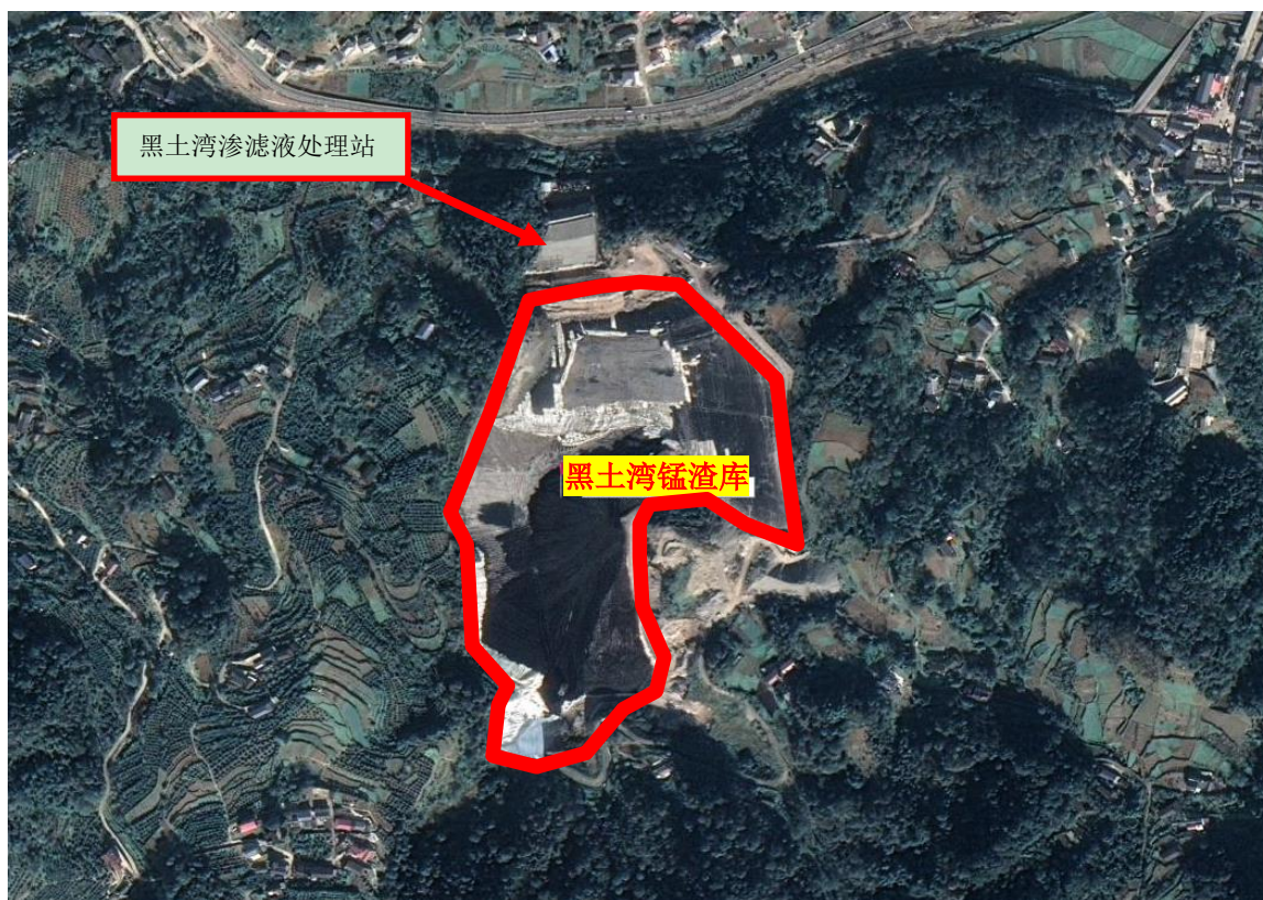
图 2.4-3 黑土湾锰渣库现状
