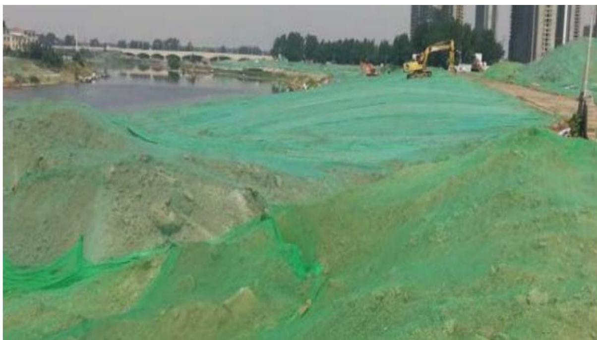
图 8.1-2 施工场地防尘网覆盖示意图
