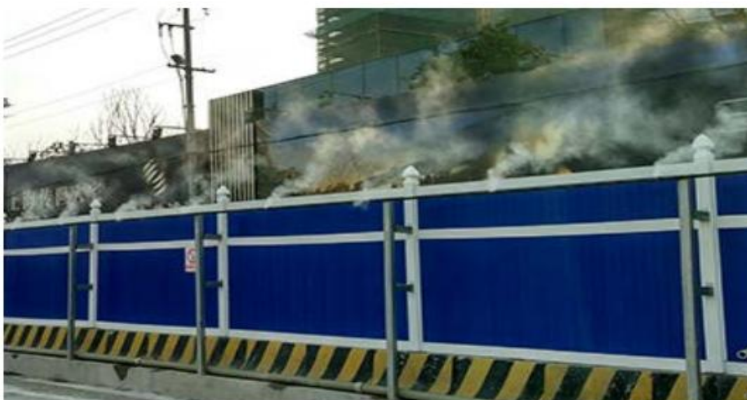
图 8.1-1 施工场地高压喷雾除尘示意图
