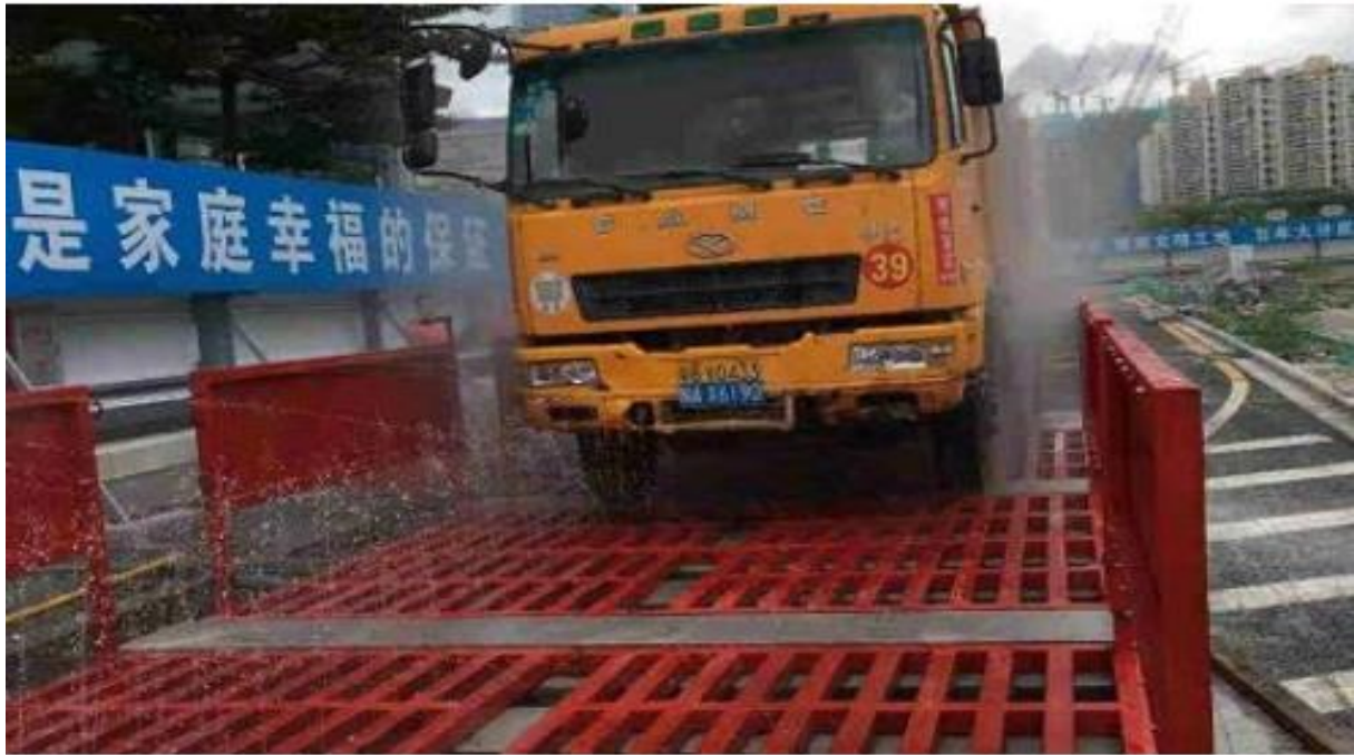
图 9.1-3 施工场地洗车平台示意图
