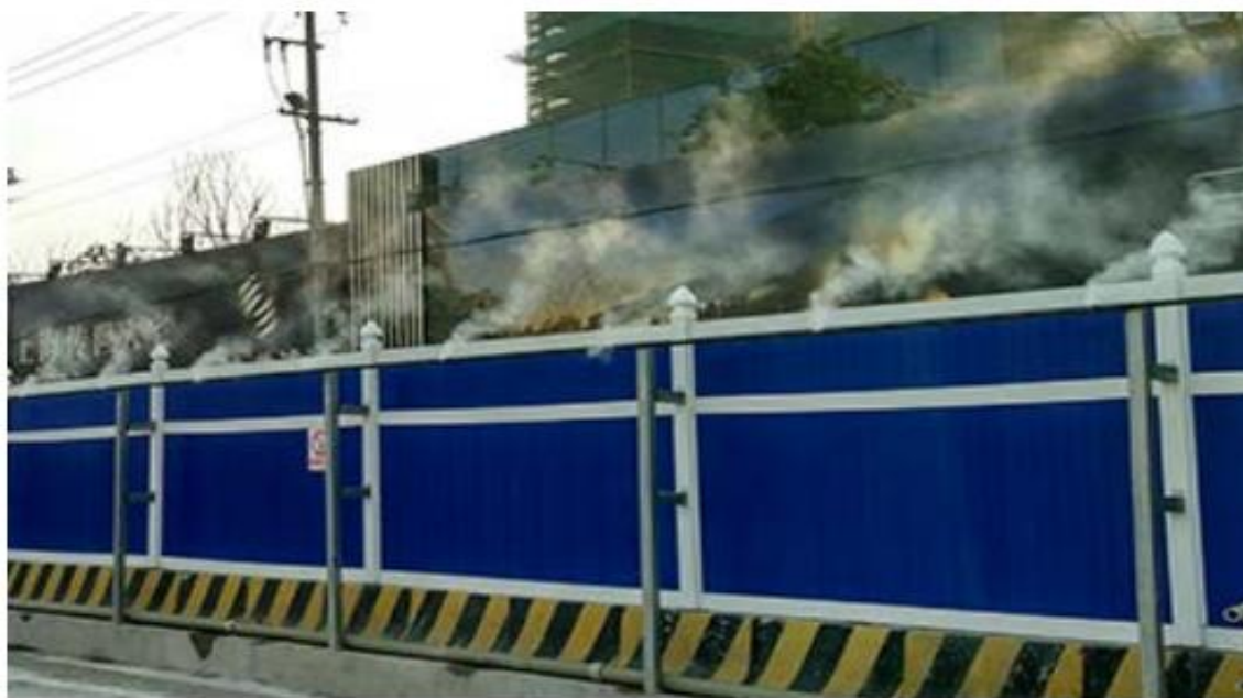
图 9.1-1 施工场地高压喷雾除尘示意图
