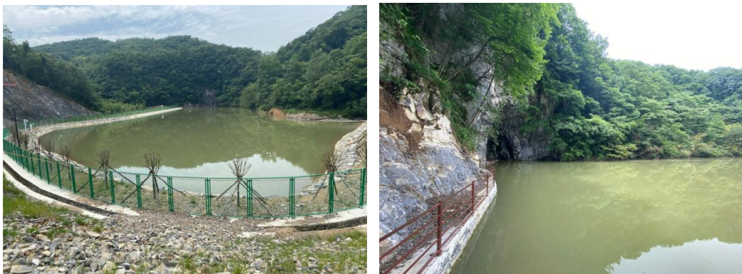
图3.1-1 夹沟子蓄水池现状照片
