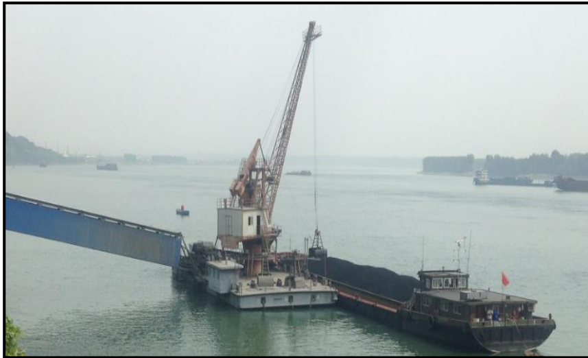
图 2.2-4 码头 4#泊位现状图
