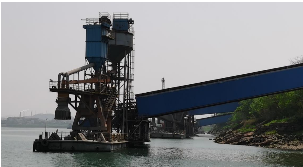
图 2.2-5 码头 5#泊位现状图
