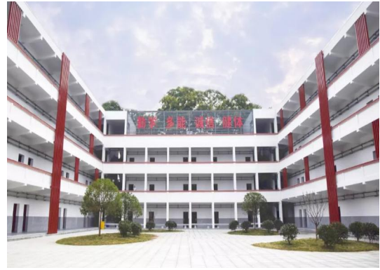
2号教学楼改造后
