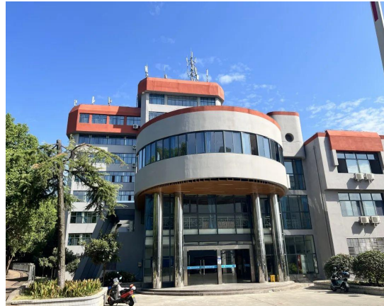
4号教学楼改造后
