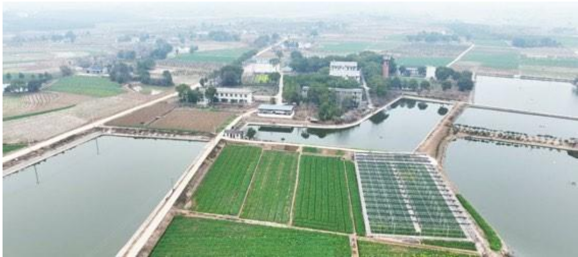
图1-3 现状建筑及水塘
