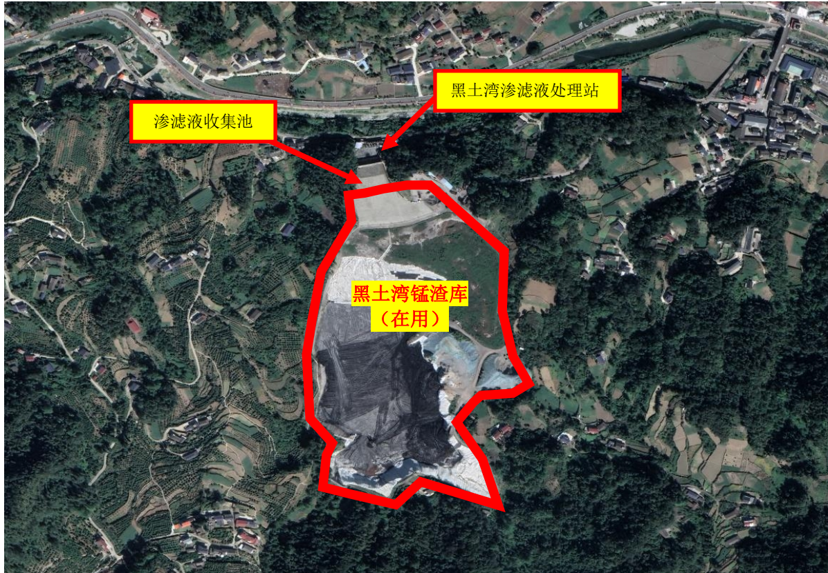
图 2.3-2 黑土湾锰渣库现状
