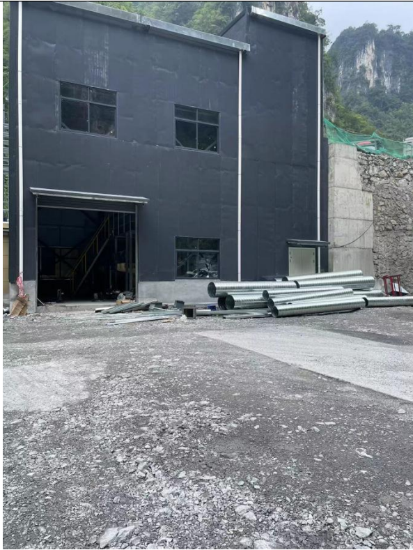
破损车间外地面未硬化
