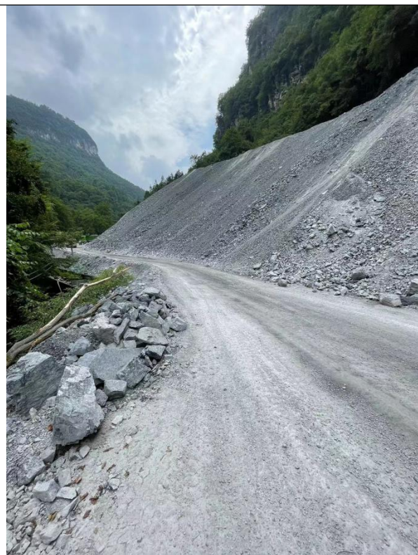
物料未进行苫盖
