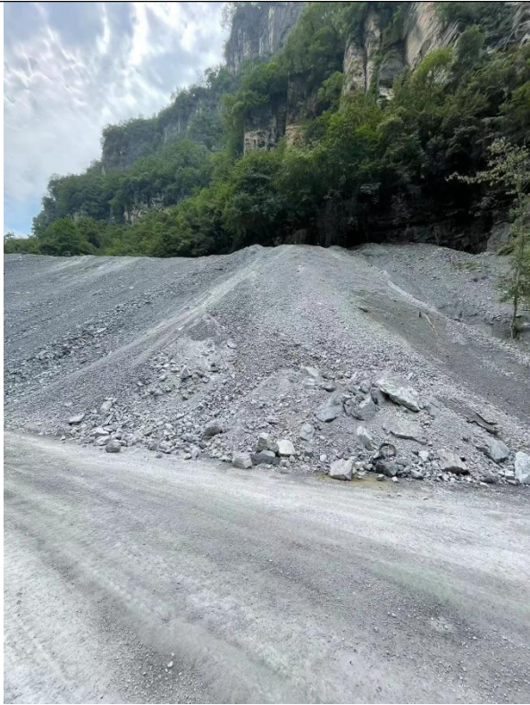
物料未进行苫盖
