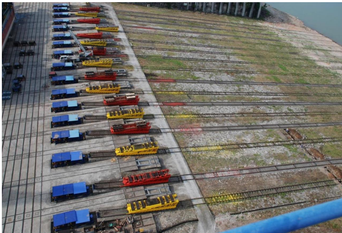
图 2.3-6 下水滑道现状（西坝岛）
