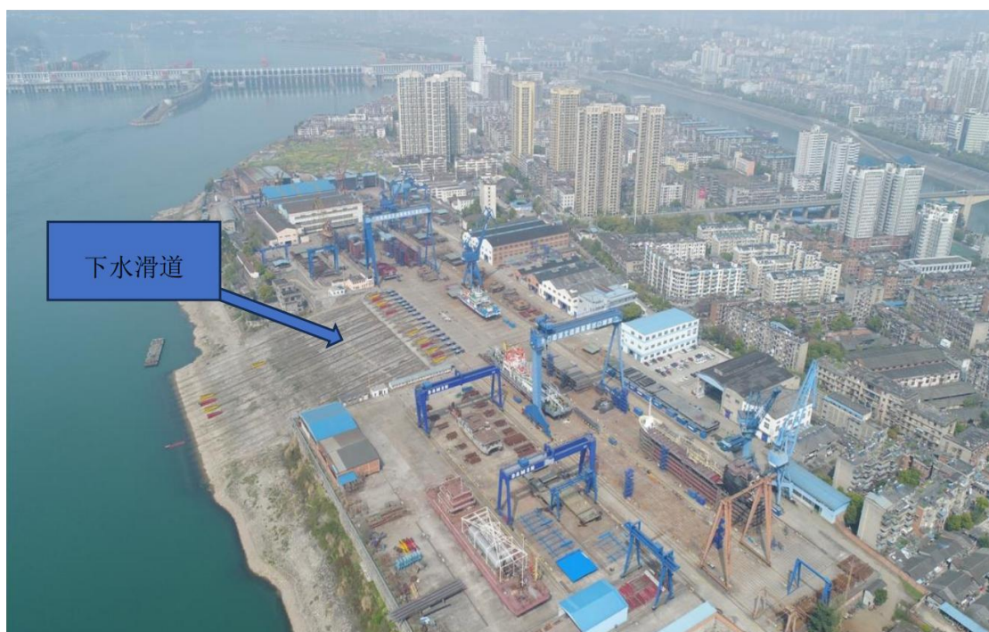
图 2.3-5 达门船厂现状（西坝岛）
