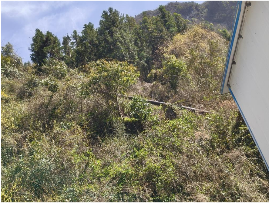
图 2.1-4 麻柳河电站现状照片
