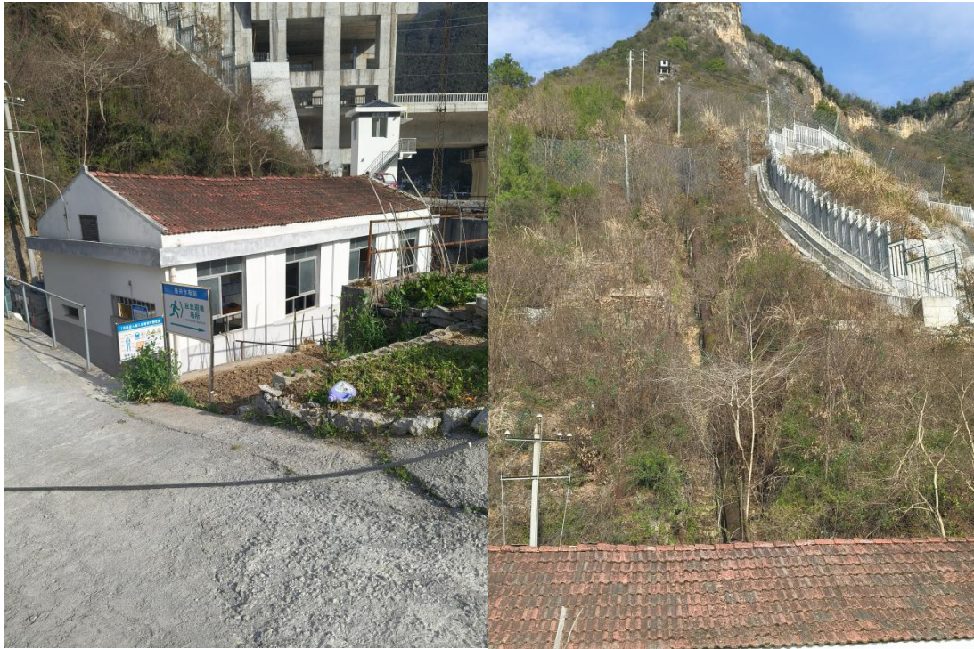
图 2.1-10 鲁兴电站现状照片
