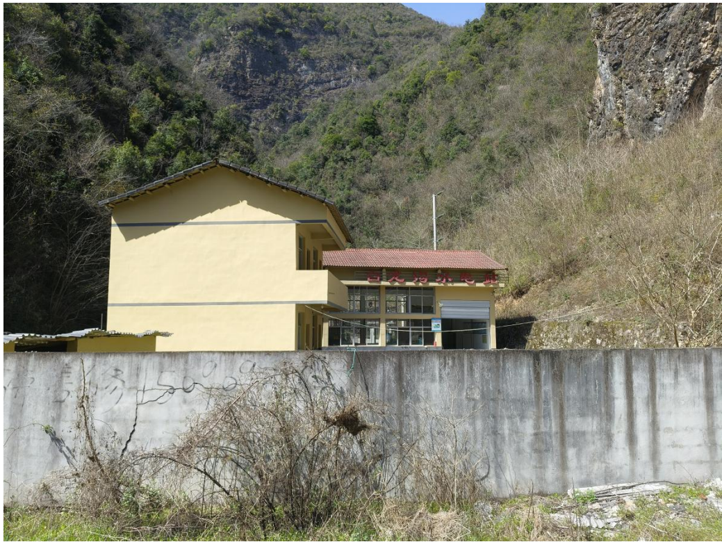
图 2.1-8 白龙沟电站现状照片
