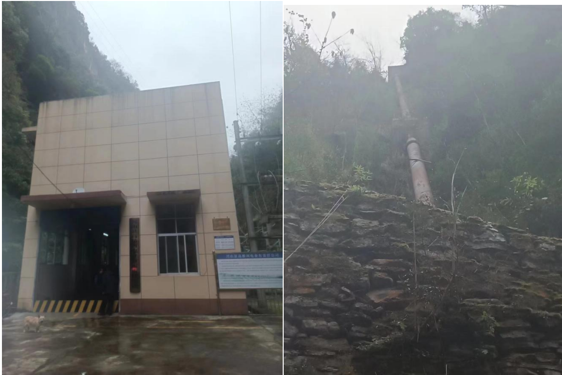
图 2.1-16 高桥河电站现状照片
