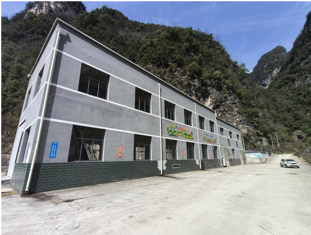
图 2.1-14 人坪河一级电站现状照片
