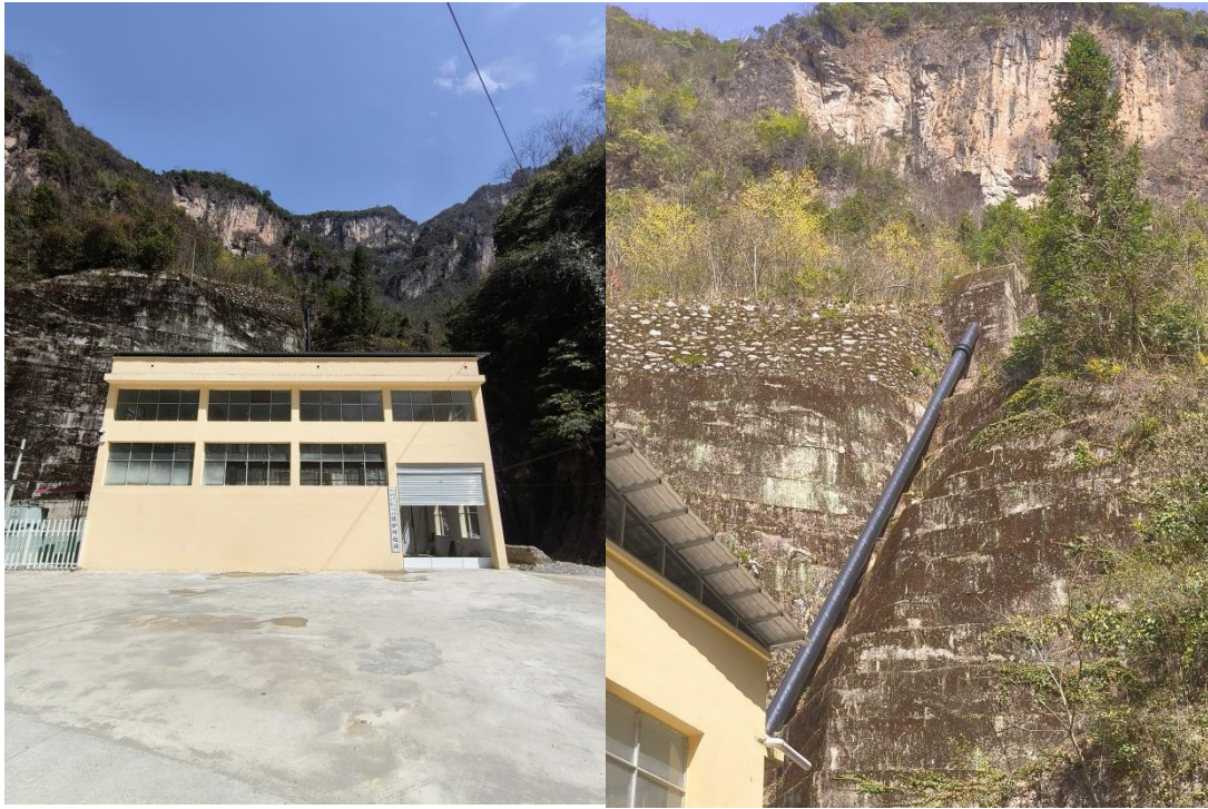
图 2.1-6 铁炉坪电站现状照片
