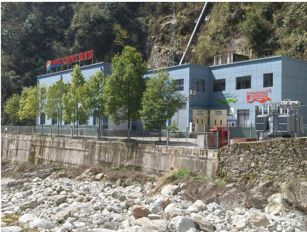
图 2.1-5 人坪河二级电站现状照片
