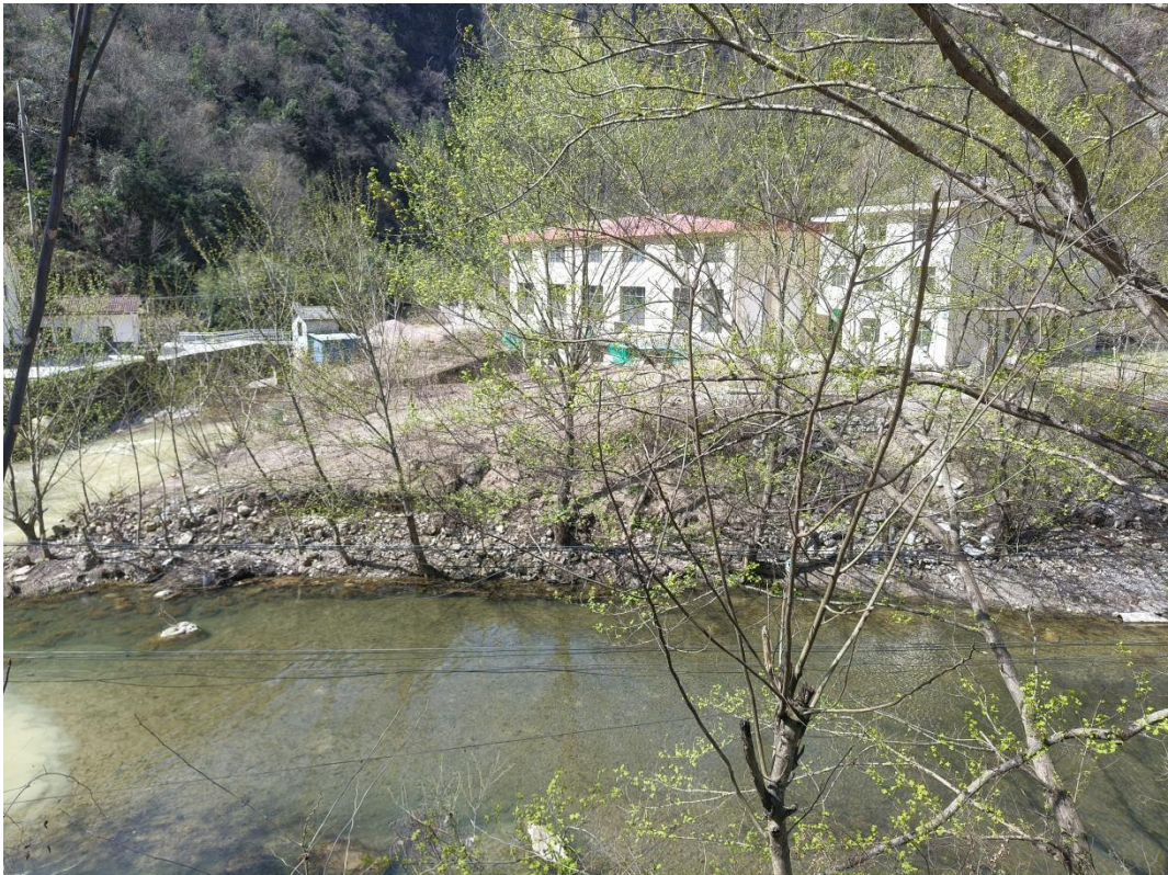
图 2.1-11 胡家湾电站现状照片
