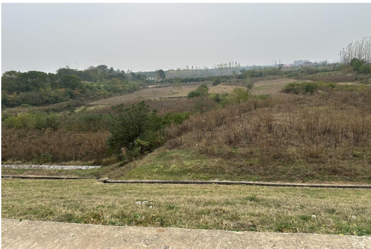
图 4.3-8 回水池坝下游生态现状
