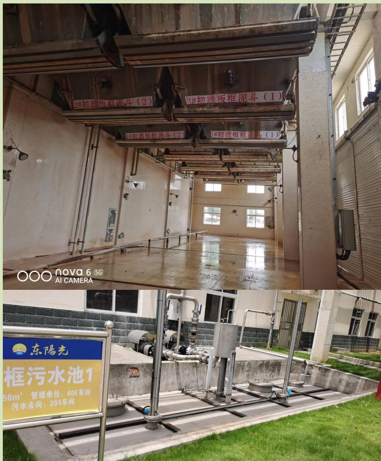
图 5.4-1 厂区现有滤渣暂存料斗间及车间外污水收集池
