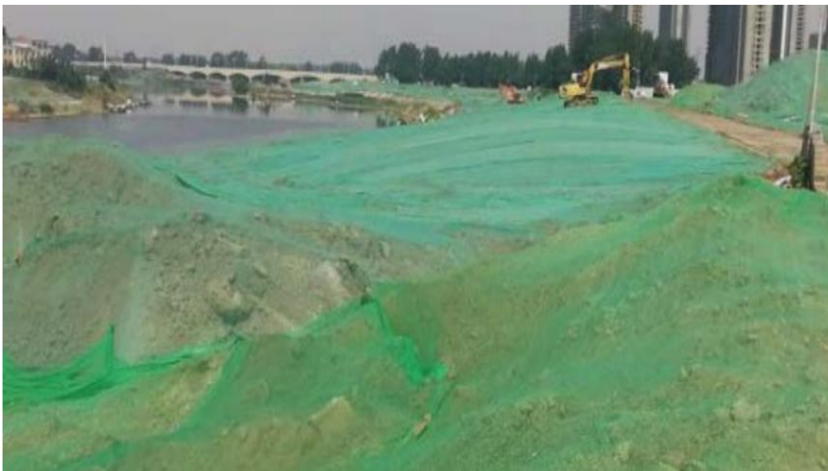
图 8.1.1-2 施工场地防尘网覆盖示意图
