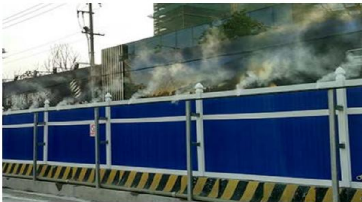
图 8.1.1-1 施工场地高压喷雾除尘示意图
