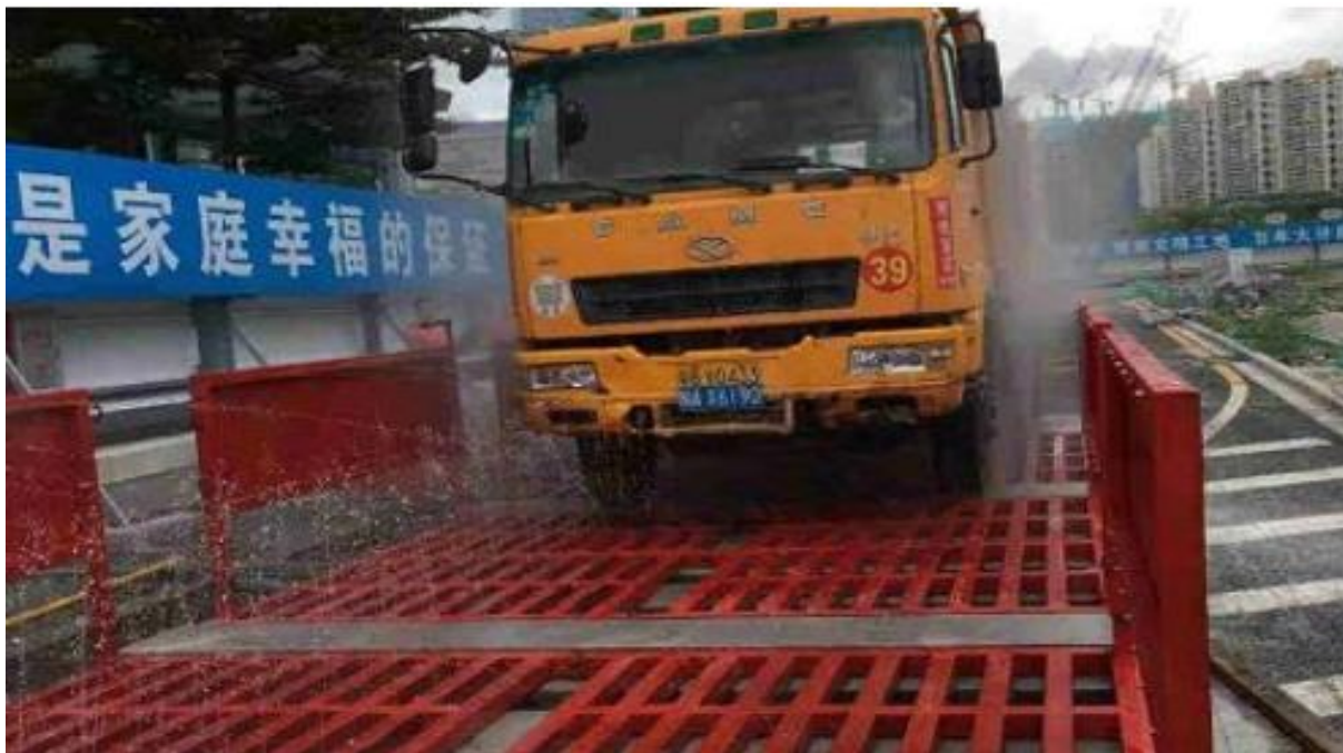
图 8.1.1-3 施工场地洗车平台示意图
