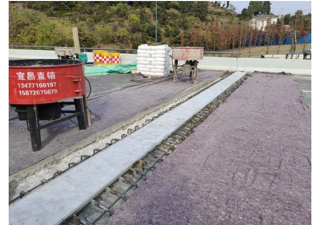
混凝土浇筑前施工准备
