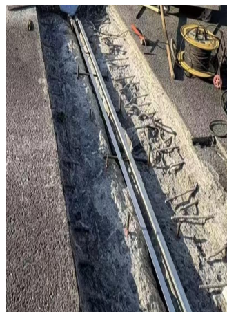
固定角钢绑扎模板
