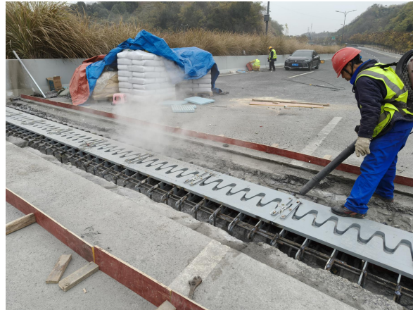
槽内浮渣清除
