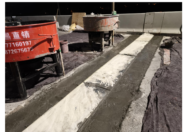
混凝土浇筑完成后
