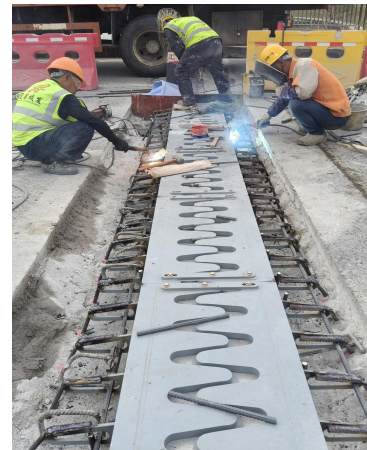
固定钢筋焊接
